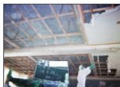
アスベスト除去工事
